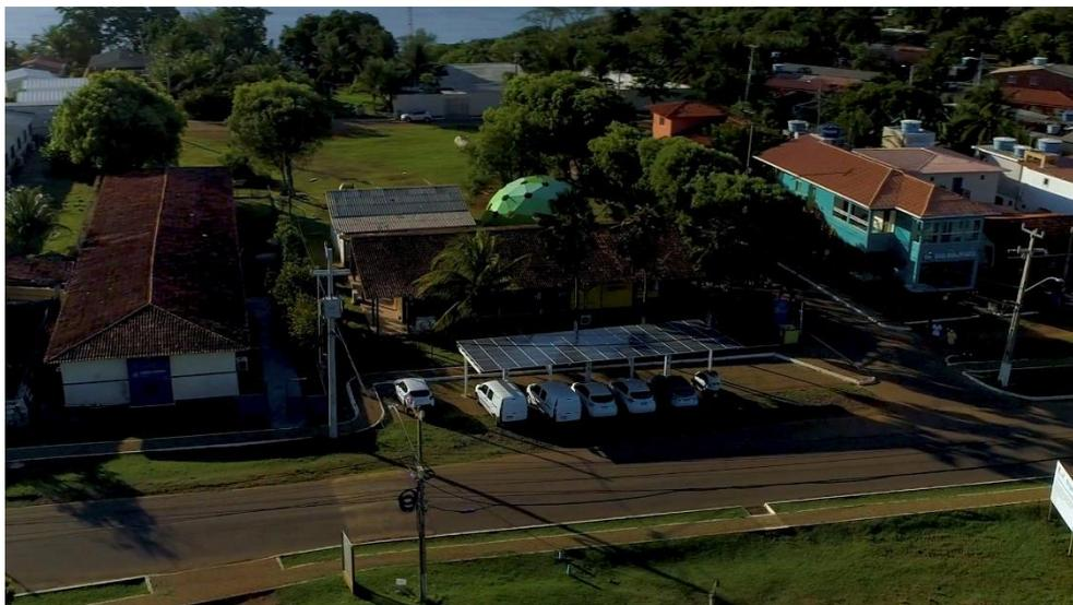
Chaque station permet d'alimenter jusqu'à six véhicules en simultané et fournit 26 MWh d'énergie par an. Cette énergie générée équivaut à 180 000 kilomètres parcourus sans émissions, en remplacement d'environ 20 000 litres de carburant fossile. Et l'excédent d'énergie est envoyé vers le réseau, pour l'usage de la communauté locale.
